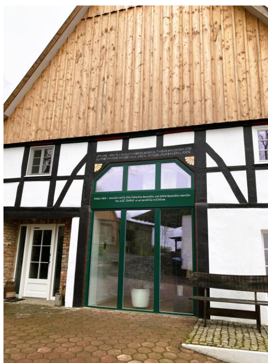
Heute ist aus dem historischen Gebäude mit Unterstützung der Denkmalpflege wieder ein schmackes Wohngebäude für die Jungbauernfamilie geworden.
