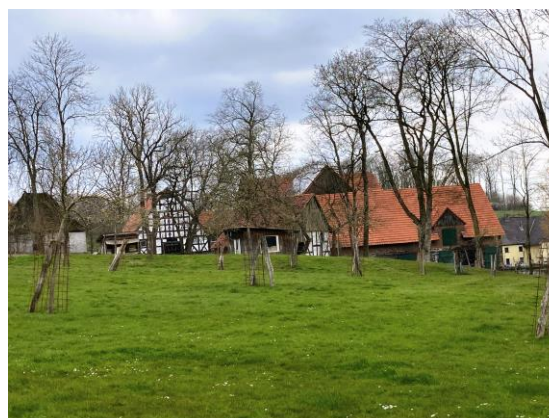
Die historische Hofanlage Kirchlinde mit ihren zahlreichen Gebäuden spiegelt bis heute die ursprüngliche Gebäudesituation der zahlreichen Klosterhöfe wider.
